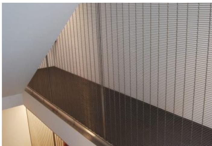
Dopo aver utilizzato la tela metallica per la ristrutturazione della parte esterna dell'edificio a Melide, lo studio Ciocca ha inserito la stessa tipologia R&R 70x3 anche sulla scala interna principale.
